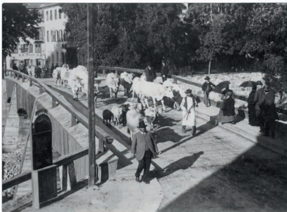
Il vecchio ponte dell'ospedale, demolito nel 1889, ora ponte della posta
