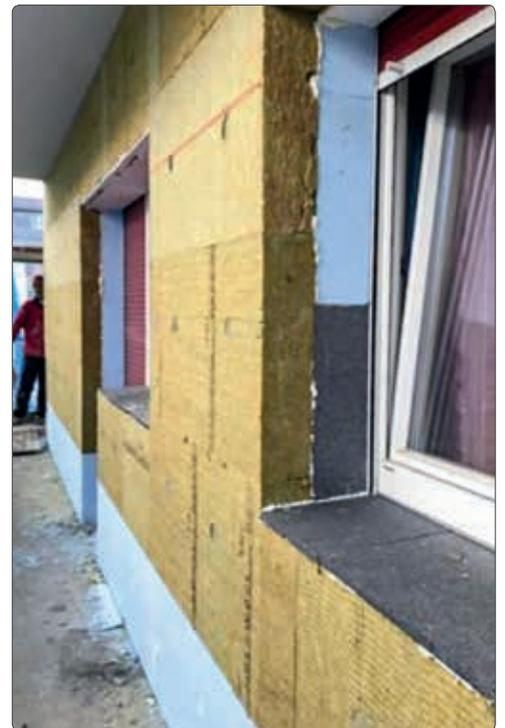
Von KlimaHaus Klasse G auf C: Wärmedämmung der Fassade, Sanierung der Balkone und Umstellung der Warmwasserbereitung auf Fernwärme machen sich bezahlt. Foto: Landesamt für Energieeinsparung
